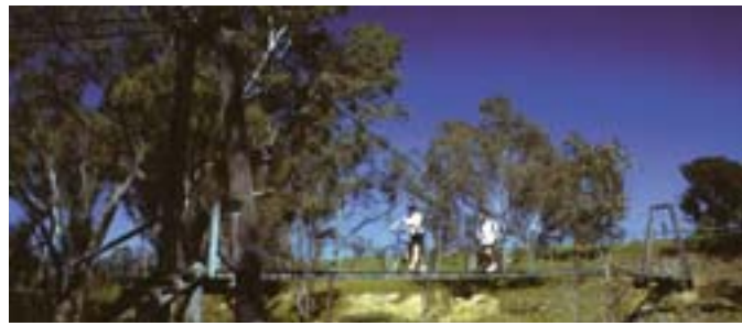
Axe Creek Swing Bridge
